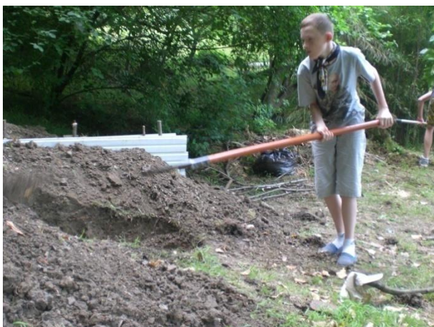
Подготовка компостных ям
